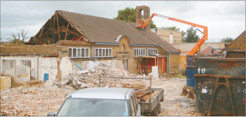
Στις φωτογραφίες φαίνεται ο παλαιός ναός που άρχισε να κατεδαφίζεται...
