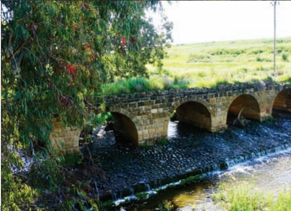
Γέφυρα Παλιομετόχου - Ποταμός Μέρικα
